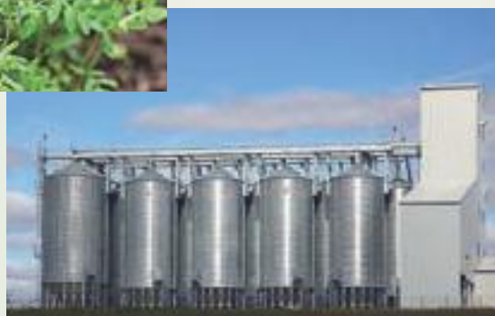
Le premier silo français 100 % bio a été construit en 2011 à Saint-Jean d'Angély (17).
